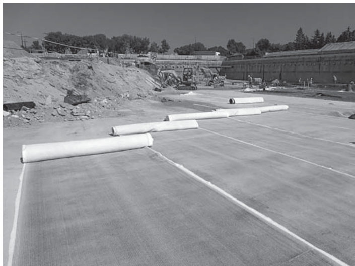
Rys. 2.14. Układanie mat bentonitowych [E6]
