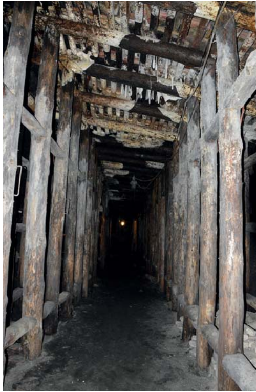
Rys. 14.5. Drewniana konstrukcja obudowy chodnika kopalnianego – fot. W. Skowroński
