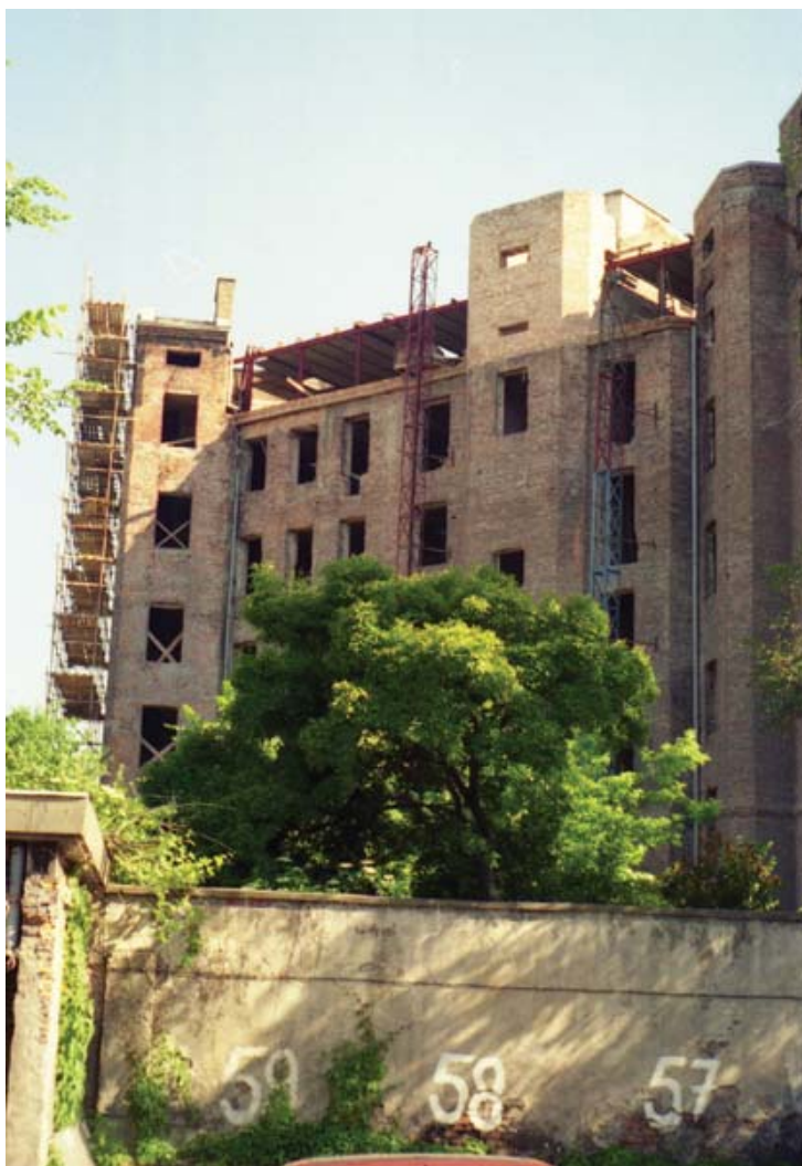
Rys. 4.2. Kompleksowa modernizacja kamienicy przy ul. Floriańskiej w Warszawie
