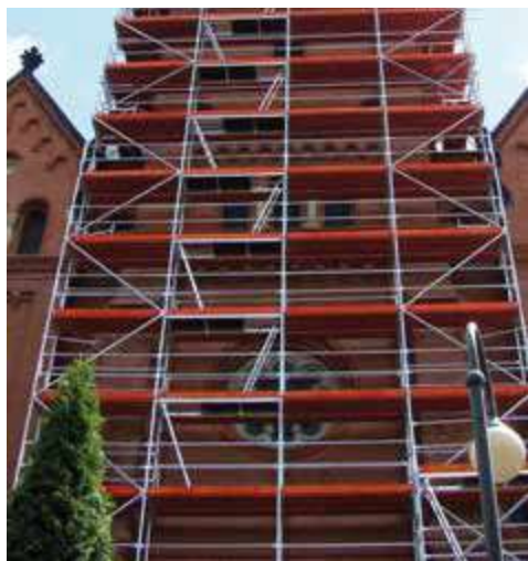
Rys. 3.154. Naprzemienny układ pomostów z drabinką w pionie komunikacyjnym na rusztowaniach ramowych
