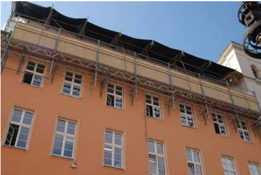
Rys. 5.13. Pomost przy okapie zabezpieczony słupkiem 2 m z poręczami oraz ogrodzeniem siatkowym i płytami OSB
